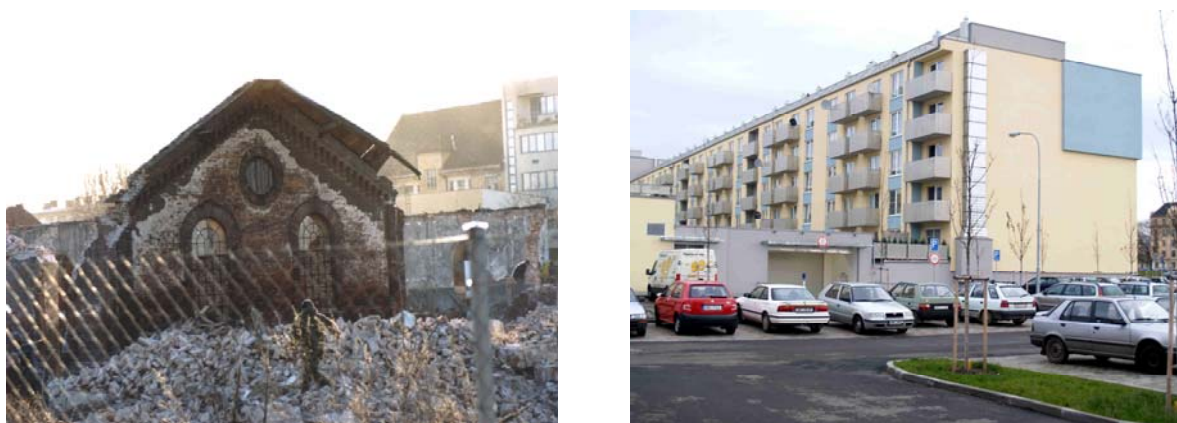
Obr. 3: Oblast „Zderadova centra“ v průběhu demolice a po skončení revitalizace
